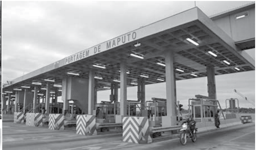
aménagement sur la N4
