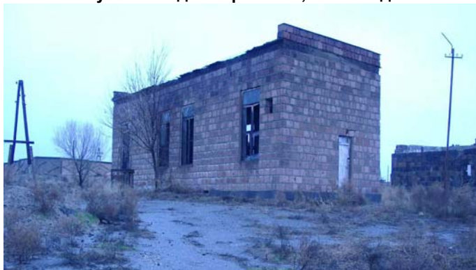
Рисунок 2.2 Здание решеток, г. Эчмиадзин
