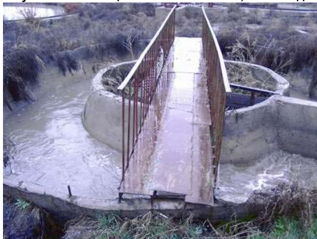
Рисунок 2.4 Тангенциальная песколовка, г. Эчмиадзин
