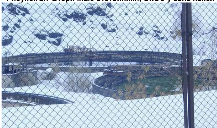
Рисунок 2.7 Вторичные отстойники, ОКОС у села Кахси
