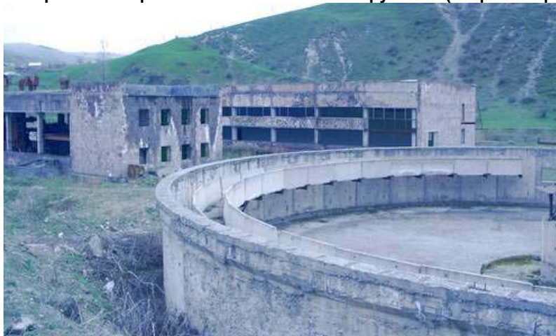
Рисунок 2.14 Незавершенное строительство очистных сооружений (вторая очередь), г.Ванадзор
