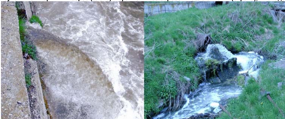
Рисунок 2.15 Аварийный сброс (слева) в сравнении со сбросом после очистки (справа), г.Ванадзор
