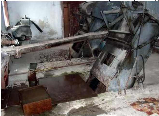
Рисунок 2.3 Решетки с механическими граблями, г.Ванадзор
