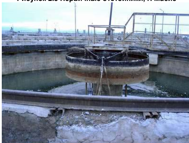
Рисунок 2.5 Первичные отстойники, г. Масис
