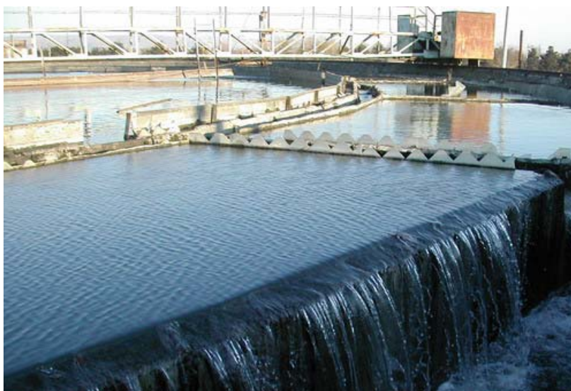
Рисунок 3.10 Первичный радиальный отстойник в работе. Переливы.
