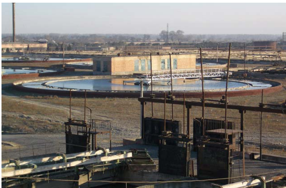
Рисунок 3.8 Песколовки и первичные отстойники в работе.
