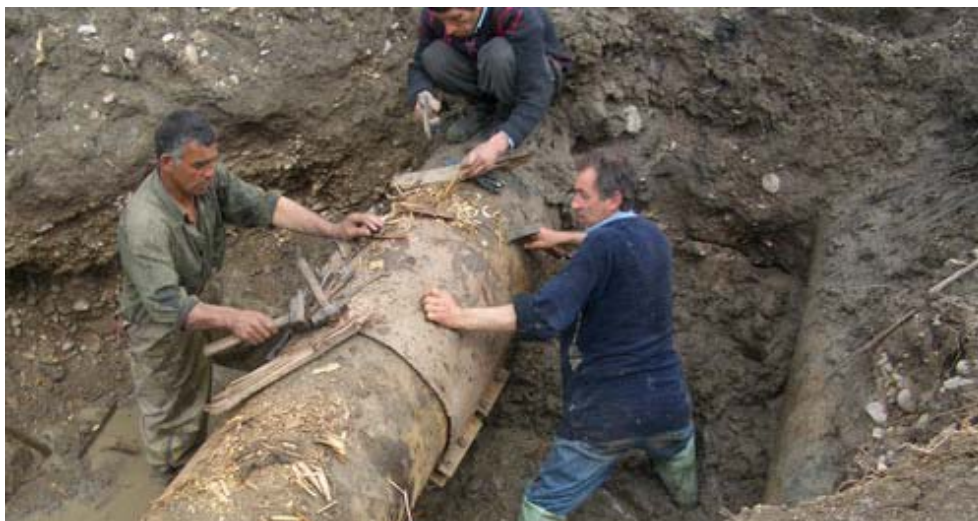
Рисунок 0.1 Ремонт магистрального водовода посредством установки хомута, г.Марнеули.
