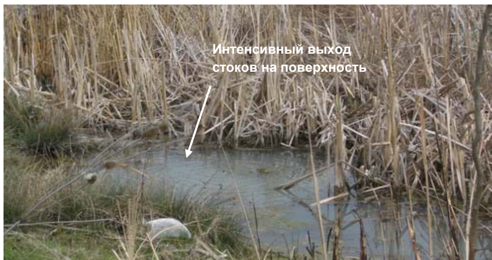
Рисунок 0.1 Коллектор Жинвали-Тбилиси. Интенсивный выход стоков на поверхность земли через повреждение свода коллектора.
