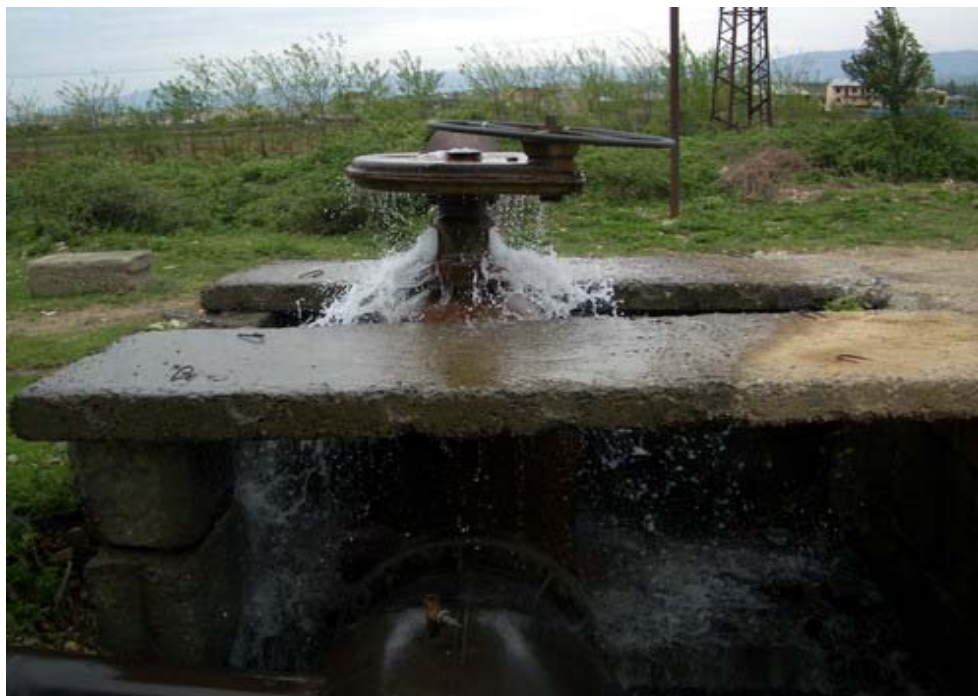
Рисунок 0.2 Протекающая задвижка Ду 800мм на напорном водоводе ВНС-2, Кутаиси
