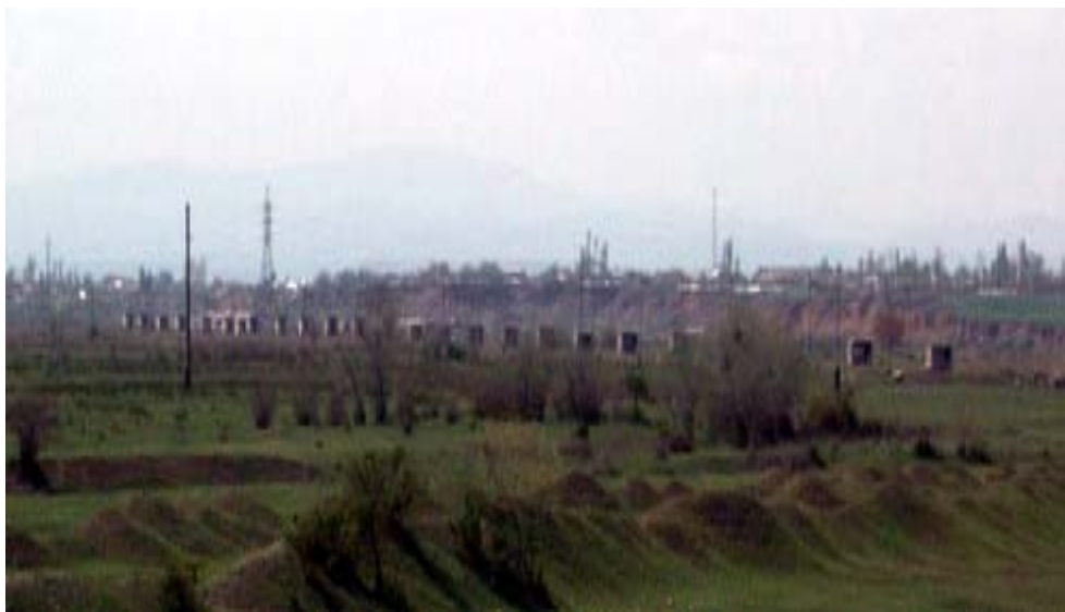
Рисунок 0.3 Скважинные павильоны нового водозабора
